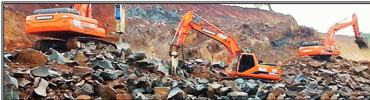
Figura 10: Escavadeiras hidráulicas acopladas com rompedores hidráulicos para o desmonte da rocha e com conchas para o manuseio e carregamento.
