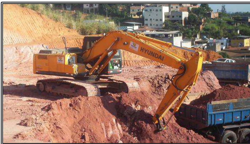
Figura 9: Escavação do solo com a utilização de escavadeira hidráulica.
